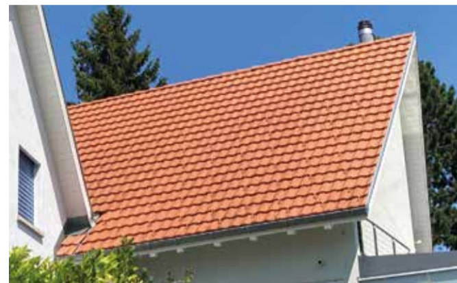
Das Dach circa ein Jahr später.
