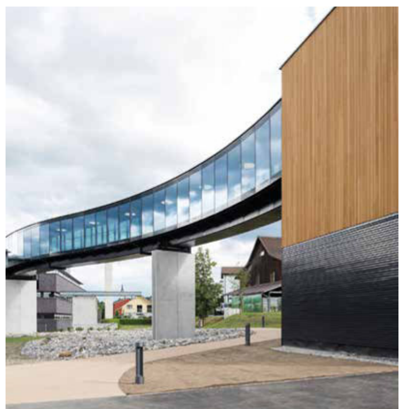
Die elegant geschwungene Passerelle verbindet neu das Guido Zäch Institut (GZI) mit dem umgebauten Hotel.
