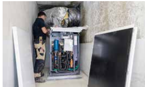
Durch eine direkte Platzmontage im Keller passt die Wärmepumpe auch in enge Räume.
