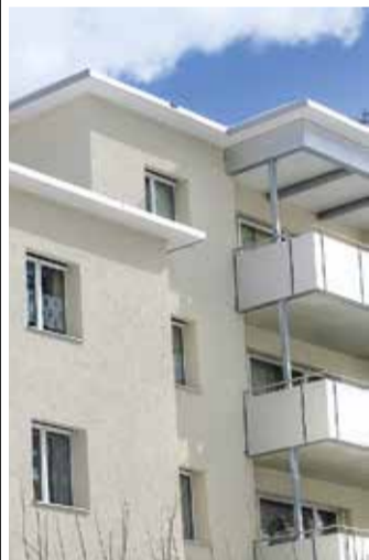
Die sanierten Gebäude überzeugen durch die moderne Aussenwärmedämmung und die vergrösserten Balkone.
