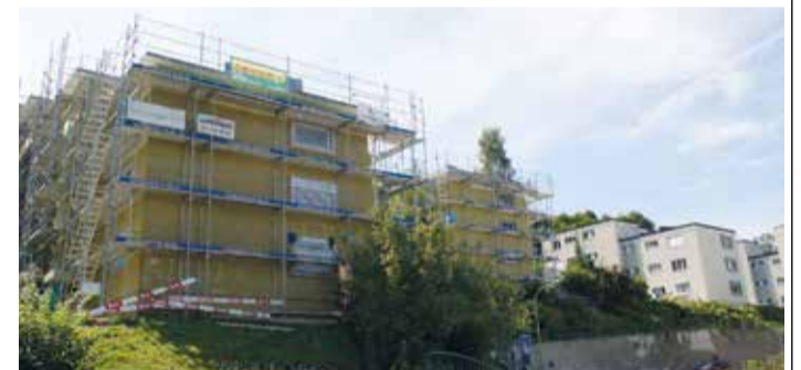
Links die sanierten Gebäude, rechts die Häuser der Wohnbaugenossenschaft Gess mit den alten Fassaden von 1962.
