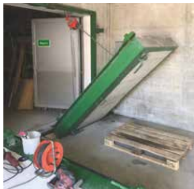
Rückbau von Zivilschutzanlagen
