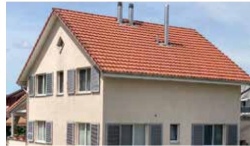
Das Dach circa ein Jahr später.
